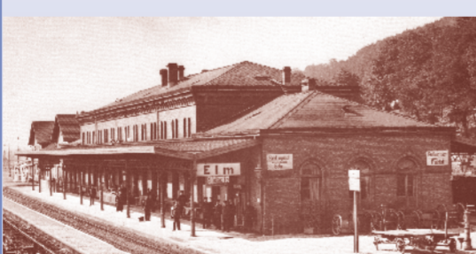
Empfangsgebäude des Bahnhofs Elm (1873-1945)
