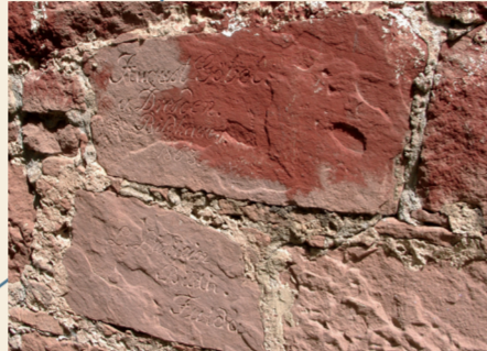
1863 wurden wohl Restaurierungsarbeiten durchgeführt.
