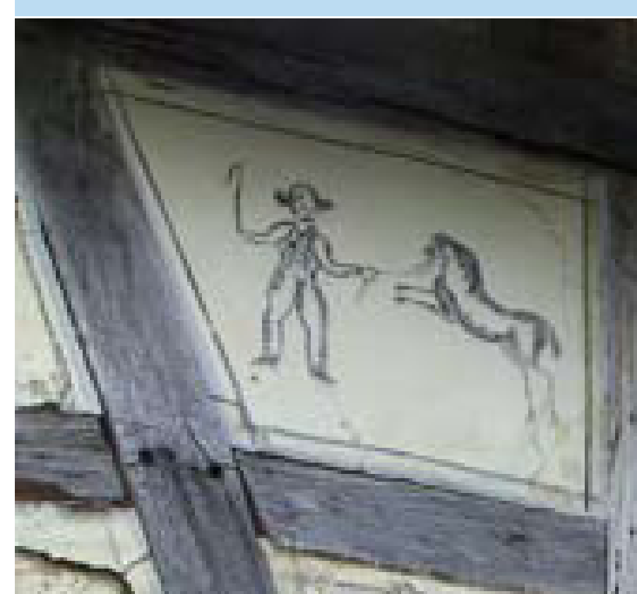
Im Fachwerk der Flederichsmühle wurde eine Malerei freigelegt, die einen Dompfeifer oder etwas ähnliches darstellt.
