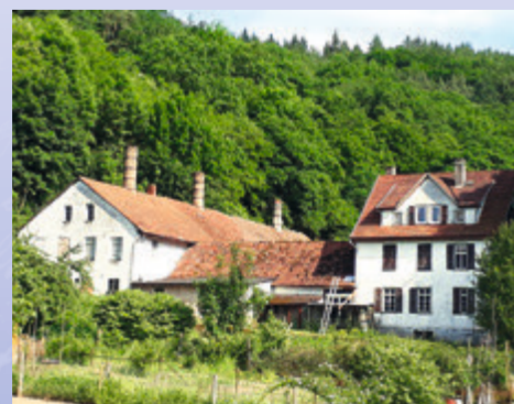
Anwesen der ehemaligen Bimssteinfabrik
